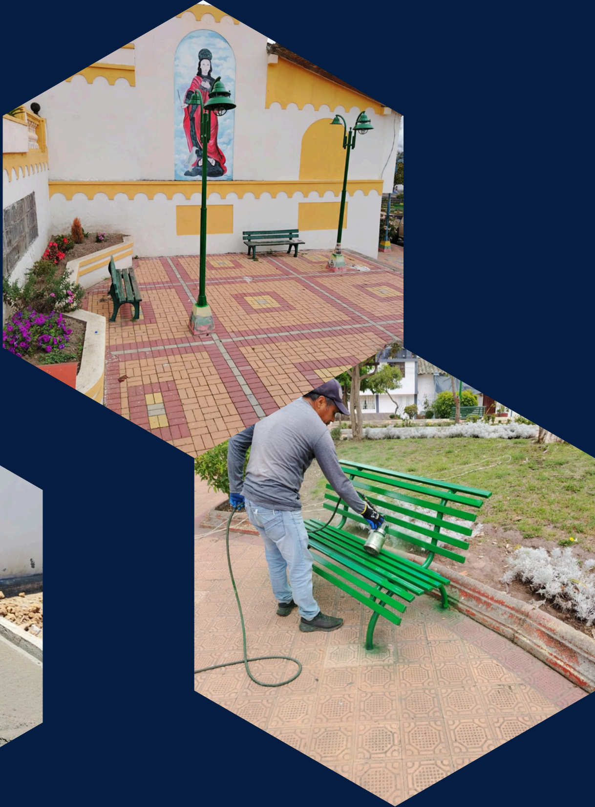
ARREGLO FACHADA DE LA IGLESIA Y PARQUE CENTRAL
